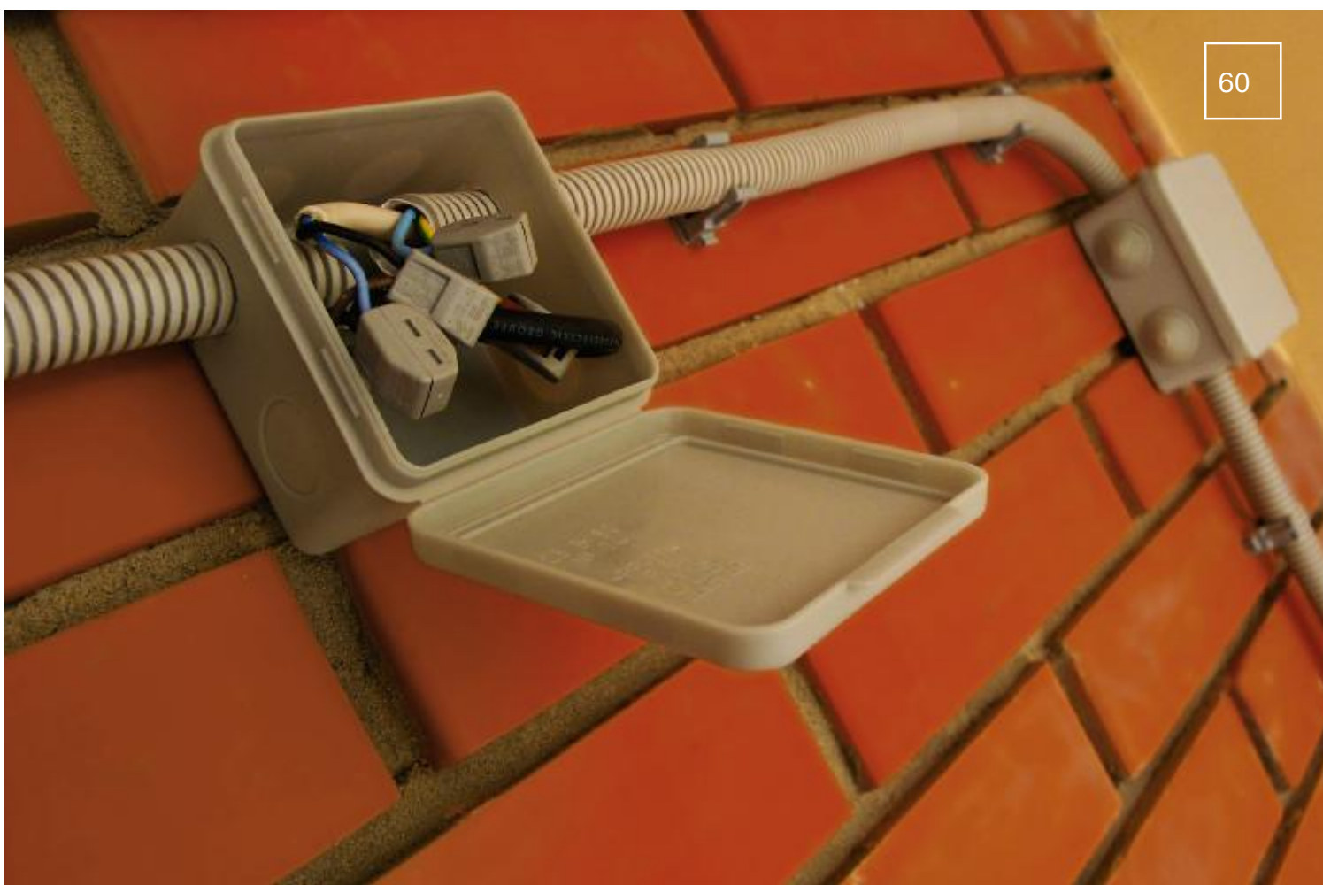
Фото 60. Монтаж открытой электропроводки на летней веранде загородного дома.
